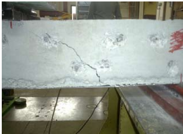
Figura 9: fessurazioni a rottura per taglio
